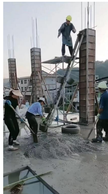
图 2 施工高度为楼地面到当前柱子浇捣部分的顶端
